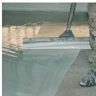
Applicering av membran för hand
